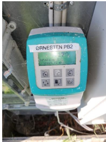
Foto 5 a og b: Til venstre ses styreskabet ved PB2. Til højre ses flowmåleren efter opstart af pumpen.
