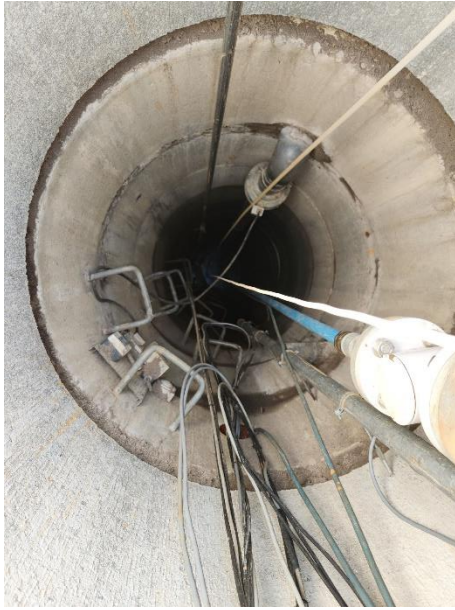
Foto 4a og b: Til venstre ses det indre af perkolatpumpebrønd PB1. I bunden af brønden ses perkolat. Til højre ses skabet hvorfra pumpen i brønden styres.
