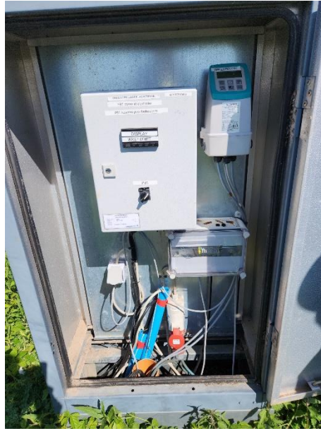
Foto 4a og b: Til venstre ses det indre af perkolatpumpebrønd PB1. I bunden af brønden ses perkolat. Til højre ses skabet hvorfra pumpen i brønden styres.
