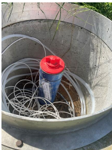
Foto 1: Boring D (DGU nr. 192.884)
