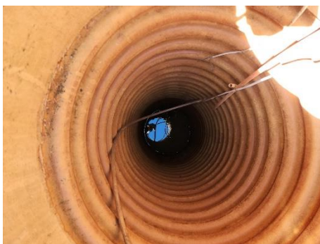
Foto 5: Perkolatbrønd B3, i bunden ses perkolat fra blandet affald. Der er ingen pumpe i B3.
