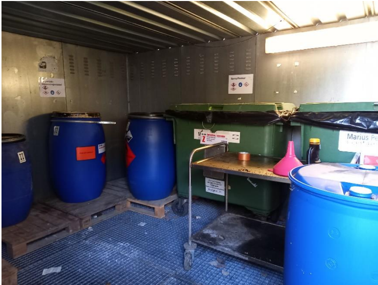
Der var indkøbt 3 nye miljøcontainere til farligt affald med indbygget sump
