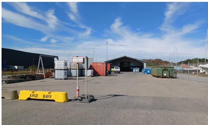
Foto af areal vest for administrationsbygningen, med vaskeplads og materialehal bagest.
