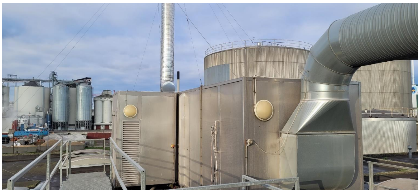
Infuser lugtrensseanlæg til luft fra udsugning ved oliebehandlende processer.
