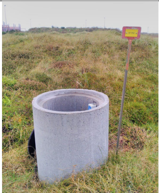
Grundvandspejling (B7P02) nord for depotet.
