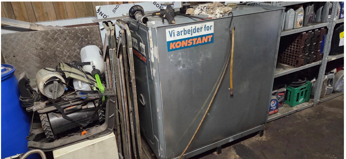
Spildolie opbevares i en dobbeltvægget spildolietank.
