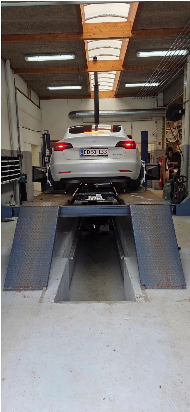
Tilstødende værksted med grav. Der er ingen afløb fra graven.
