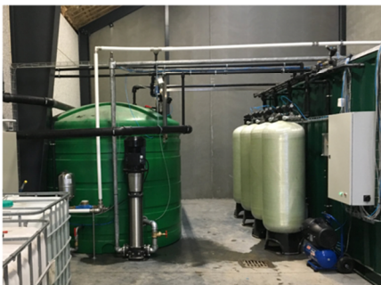
Figur 7 Biologisk vandrensningsanlæg med MBBR-teknologi
