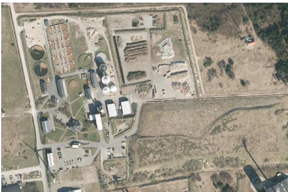
Miljøanlæg Skagen med det kommunale rensningsanlæg bagved til venstre.
