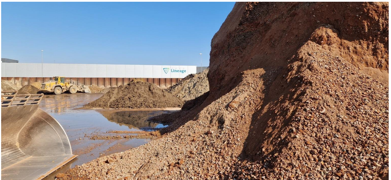
Oplag af nedknust tegl.
