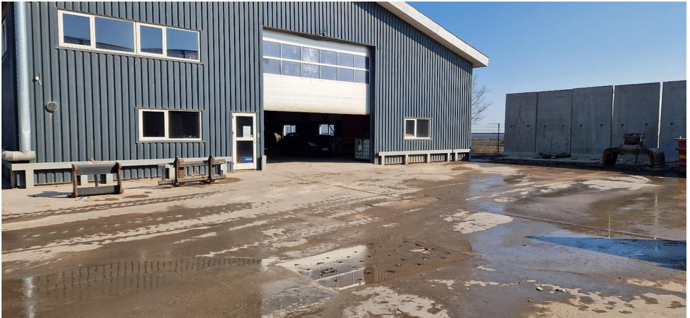
Arealet udefor lagerhallens port benyttes som tanknings- og vaskeplads.
