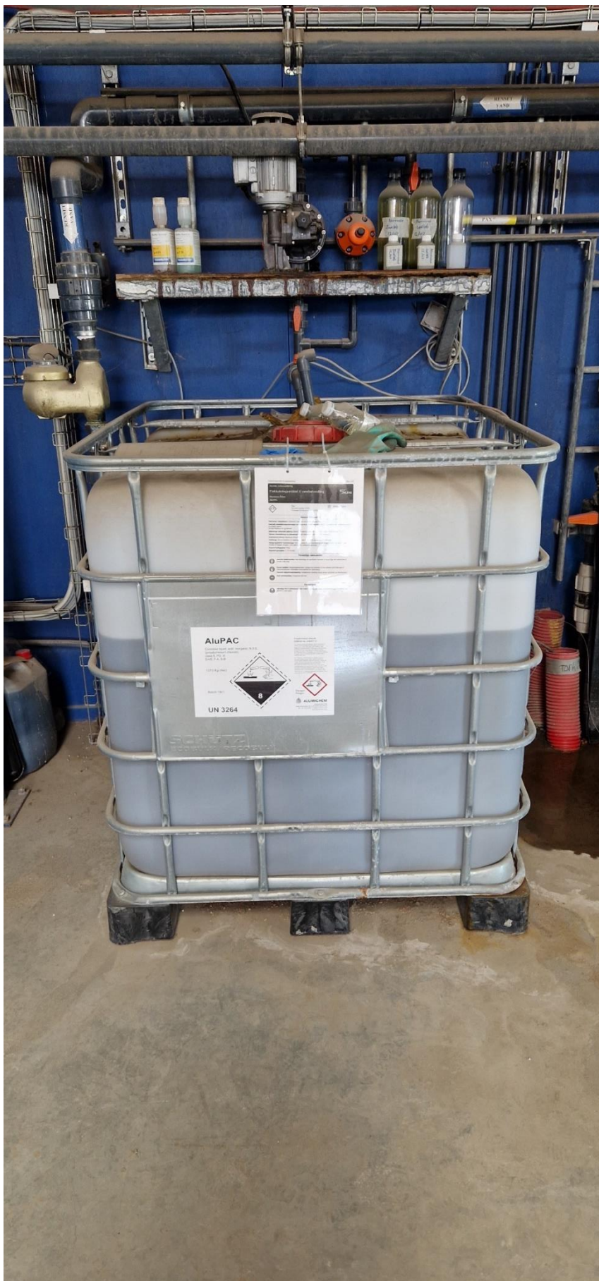
Pallettank med flokkuleringsmidlet Alu-PAC.
