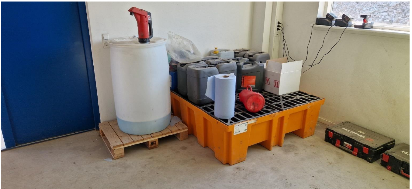
Opbevaring af diverse flydende råvarer sker på spildbakke. Dog står tønde med sprinklervæske udenfor spildbakken.
