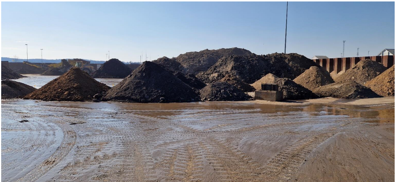
Oplag af jord. De små bunker er under kartering og afmærket, så det fremgår hvor jorden stammer fra.
