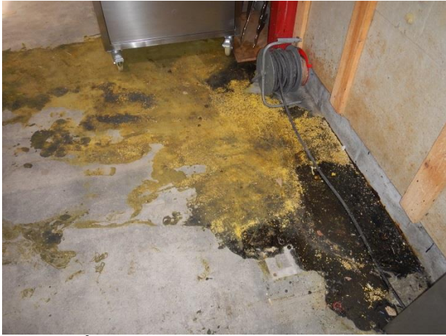
7. Spild på gulv/ opsamling med absorbtionsmiddel forsøgt – uden held. Pt spildet er udtørret og fast
