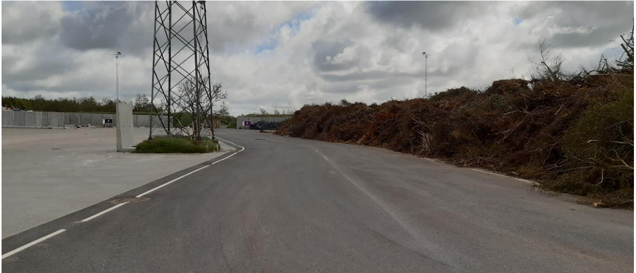
Billede 16 Bioaffaldsplads: Asfalteret kørevej, have-/parkaffald til højre på asfalteret område og område til venstre med belægningssten til brændbart affald.
