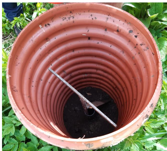
Billede 28 Håndtag til manuel lukning/åbning af spærreventil til overfladevand fra sorterings- og mellemlagerplads.
