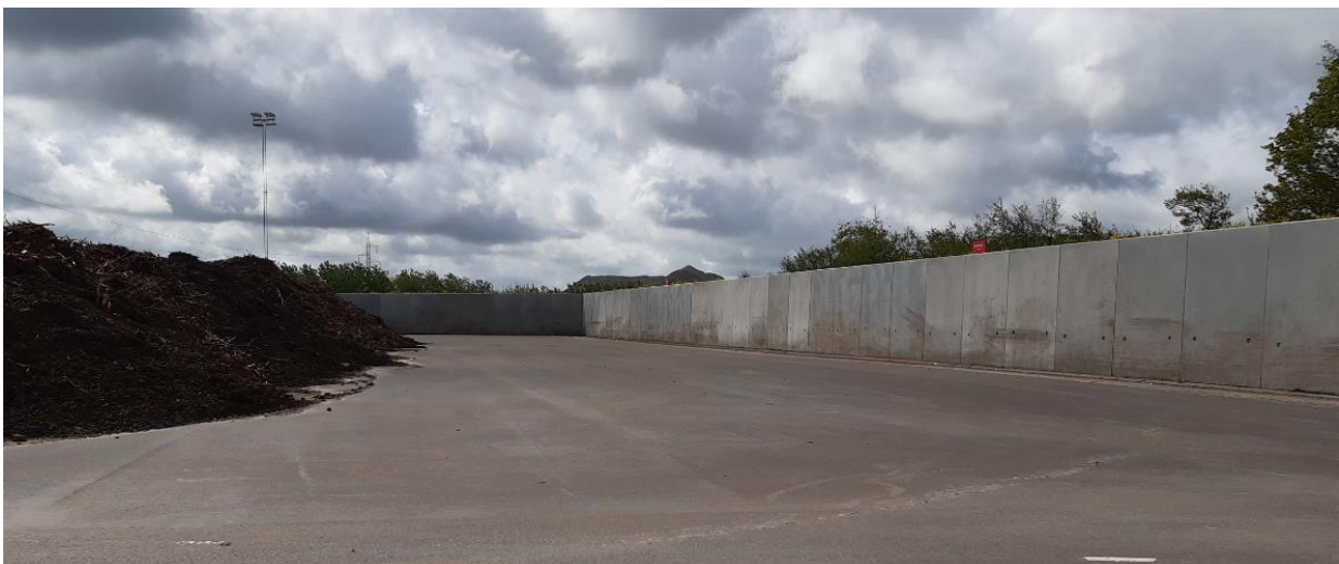
Billede 15 Dyser til overrisling af miler er markeret med røde skilte over betonvæggen.
