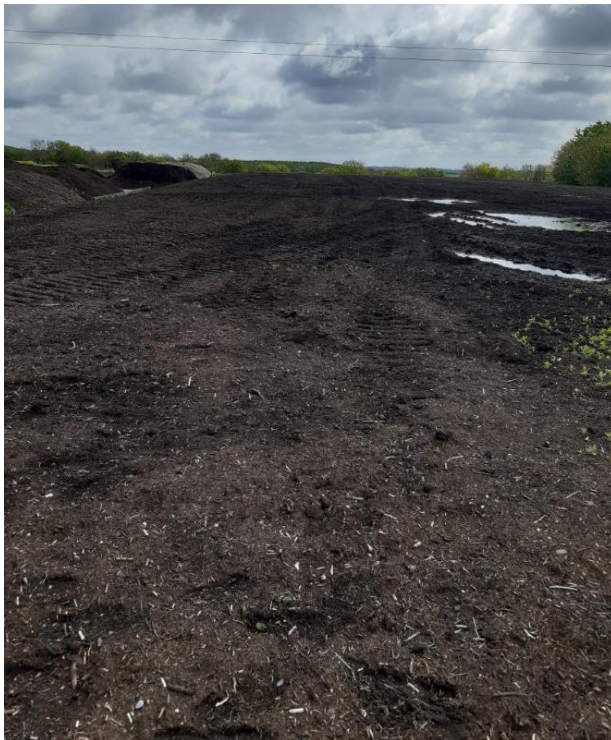
Billede 17 Afdækning af etape 4 og vand midt på arealet.
