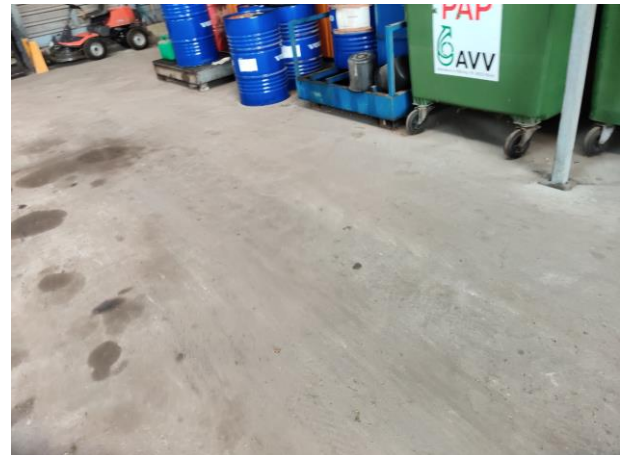
Billede 25 Opbevaring af kemikalier på betongulv uden gulv afløb.
