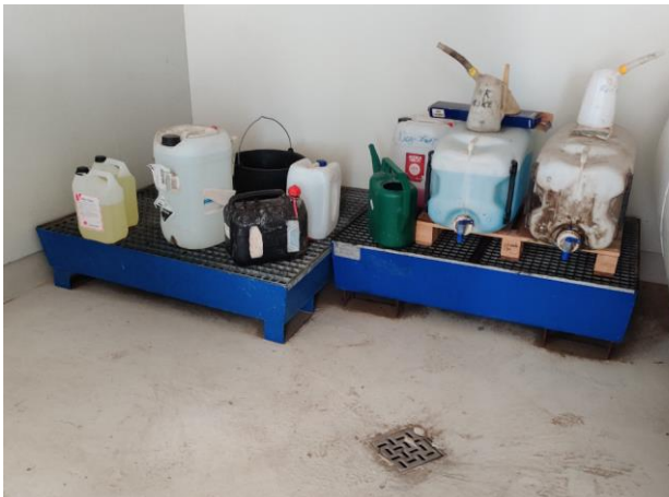
Billede 24 Opbevaring af kemikalier på spildbakker. Gulv afløb mellem spildbakker, dieselolietank og AdBlue-tank ses nederst i billedet.
