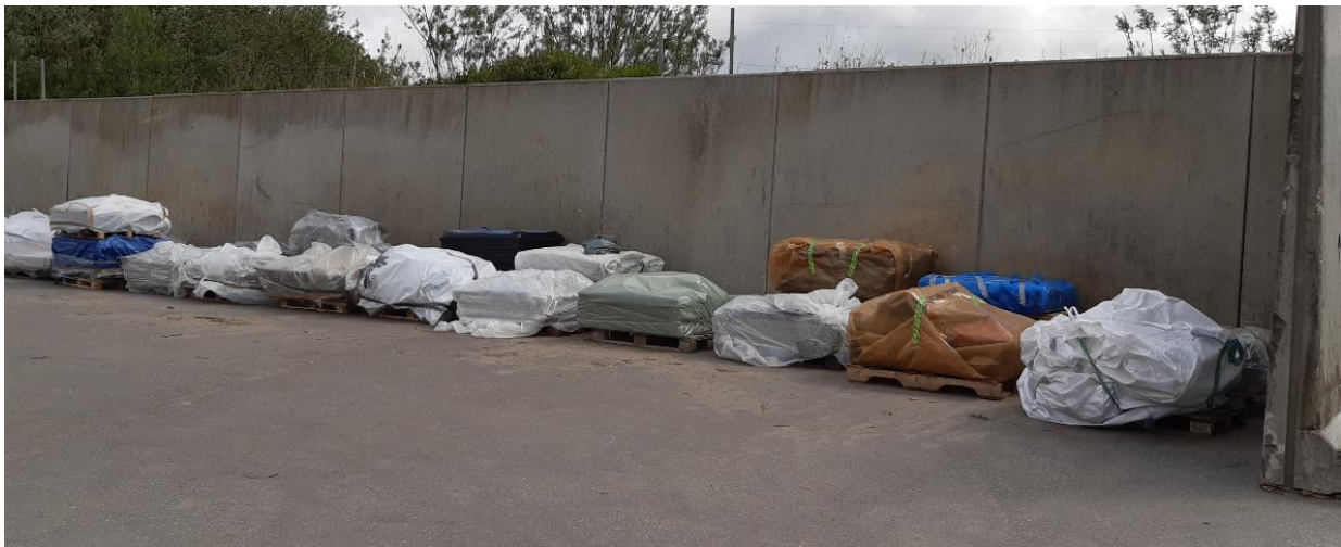
Billede 4 Emballerede asbestplader på mellemlager inden bortkørsel til deponering.
