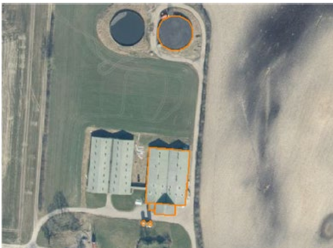
Stald- og gødningsanlæg på ejendommen Bogensevej 30A, 5620 Glamsbjerg
