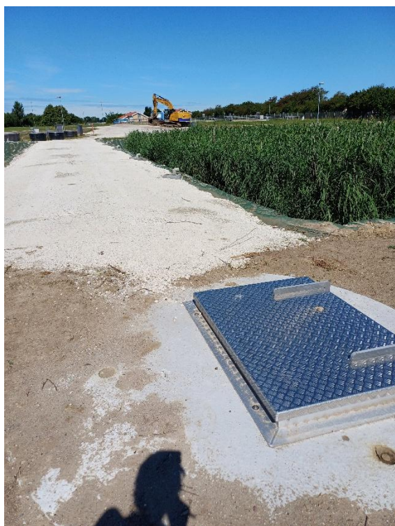
Udført ledningsarbejde mm. Samt godvækst af tagrør.
