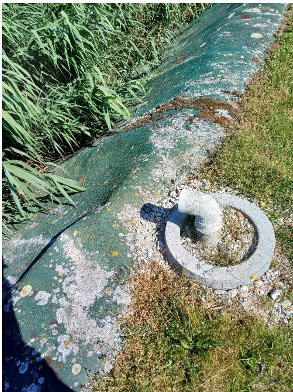
Udluftningsrør fra dræn har fået påmonteret betonring til sikring mod påkørsel.
