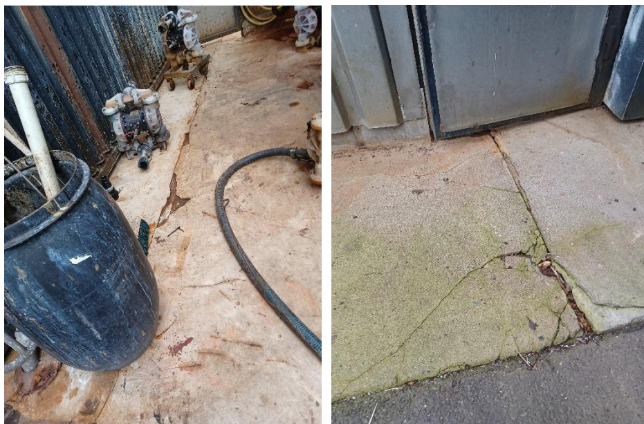
Skader på belægning ved Neutralisationsanlæg
