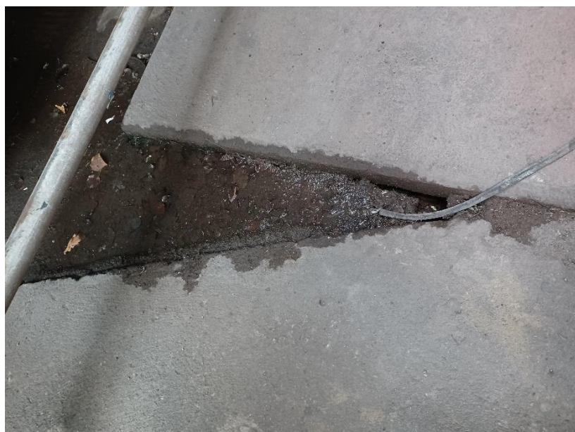
Skader på belægning ved Neutralisationsanlæg
