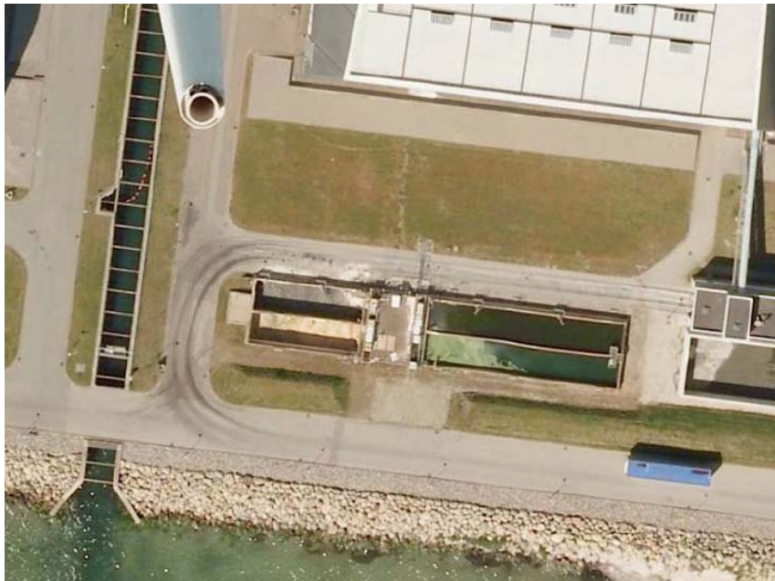
Figur 1: Sedimentationsbassiner syd for blok 1.
