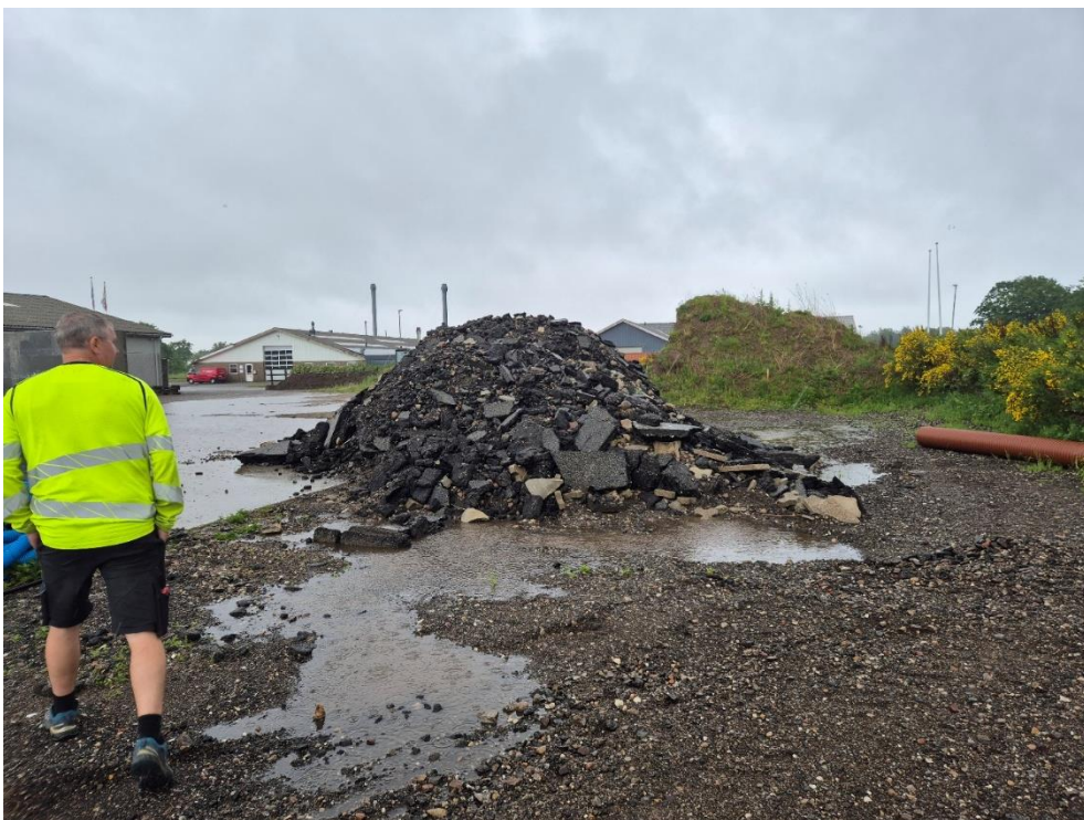
Figur 10. Asfalt til knusning (knusning sker ikke på pladsen).
