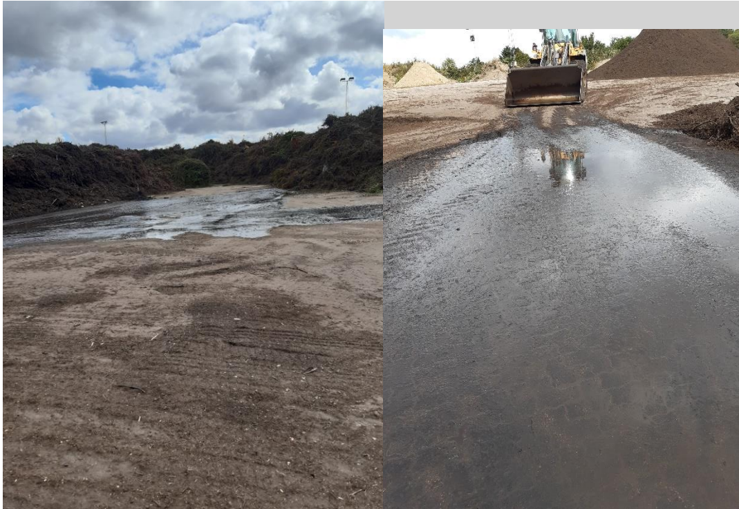
Figur 8 Tv. Lunke med vand på komposteringspladsen. Th. Belægning i lunken.
