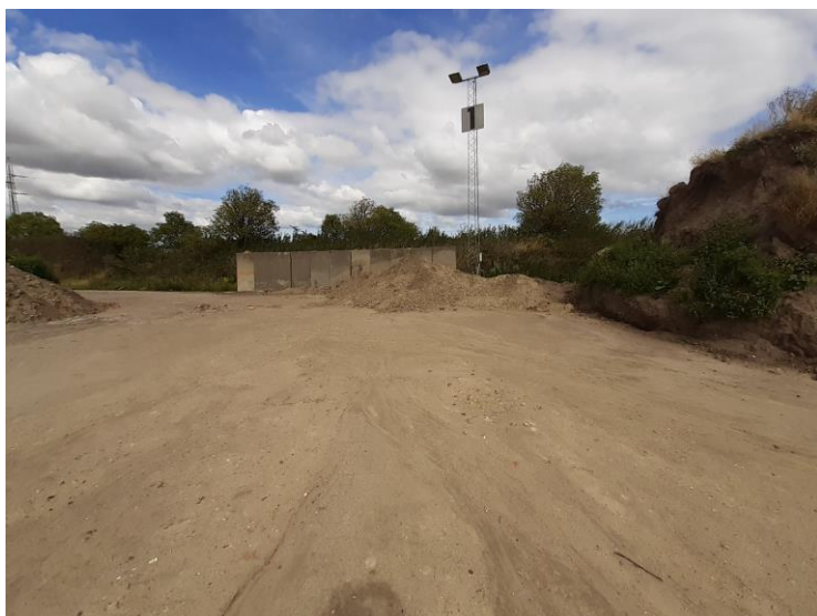
Figur 4 Areal anvendt til at rense en mindre delmængde af jordpartiet modtaget i 2015. Jordmilen i midten af billedet op mod muren viser den rensede del.
