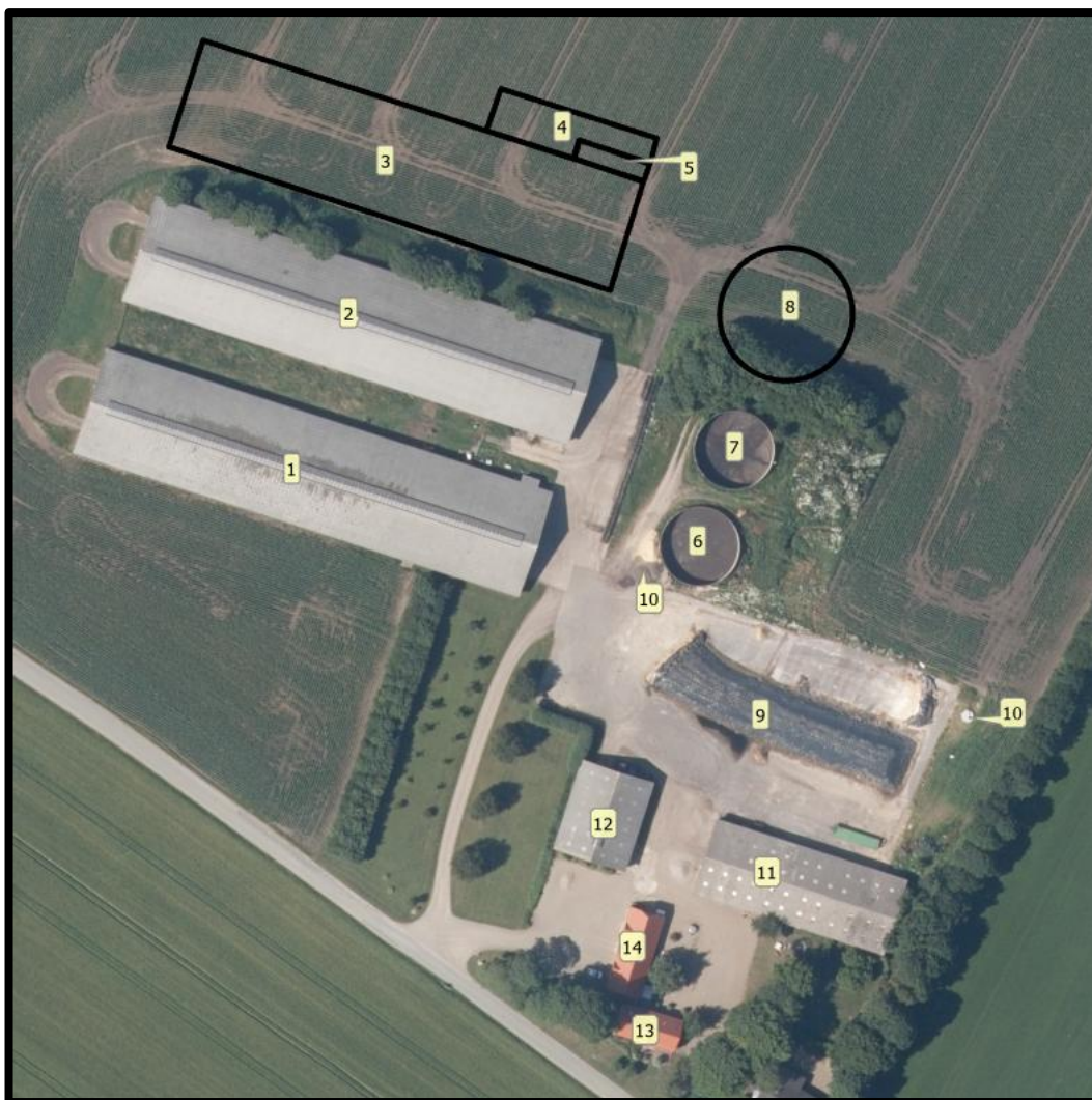
Figur 5. Oversigt over bygninger på Mallevej 92.
