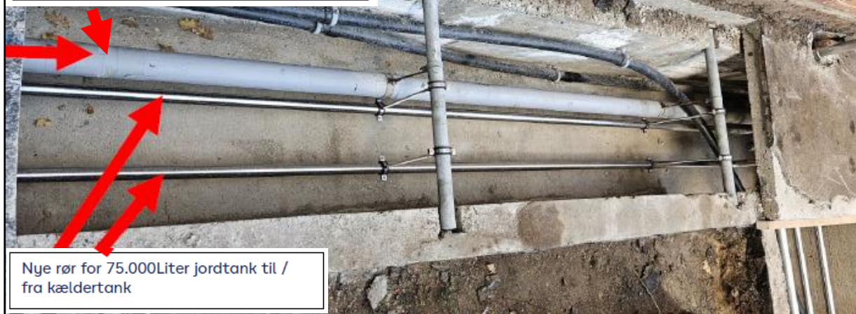
Udklip af færdigmelding fra TDC ifm. udskiftning af rør
