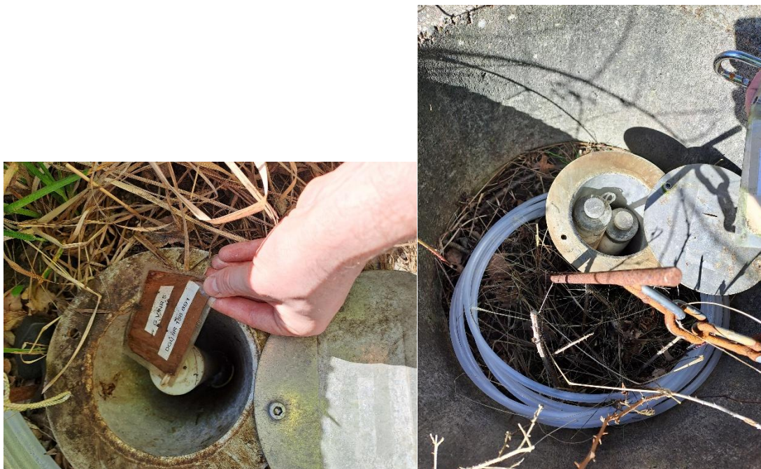
Figur 9: Til venstre grundvandsboring, til højre anden grundvandsboring tilset ved tilsynet.
