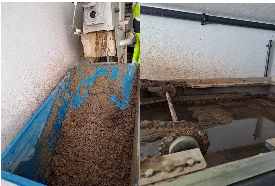
Figur 6: til venstre PFAS-holdigt slam fra skruepresse, til venstre flotationskammer i PFAS-forrenseanlæg.
