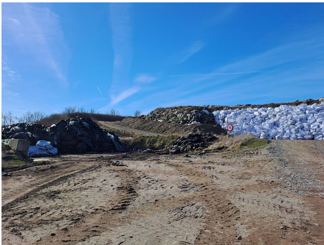
Figur 1: Åben deponeringsenhed med asbestaffald i big bags på højre side, opkørsel til top af deponi i venstre side
