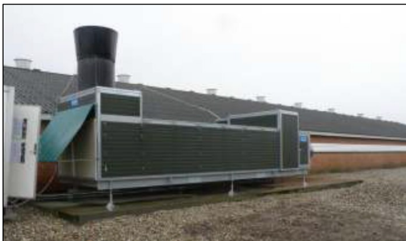
Varmeveksler ved en af staldene på Løgstørvej 113
