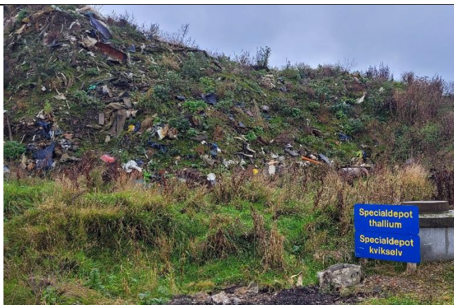
Billede 3 – Specialdepoter med Thalliumforurenet jord og kviksølvforurenet spildevandsslam placeret i etape 3.
