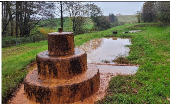
Billede 12 – Okkerudfældningsbassiner. Det første ses i forgrunden, mens sekundær bassinet svagt ses i baggrunden. Vandet udledes direkte efter udfældning.
