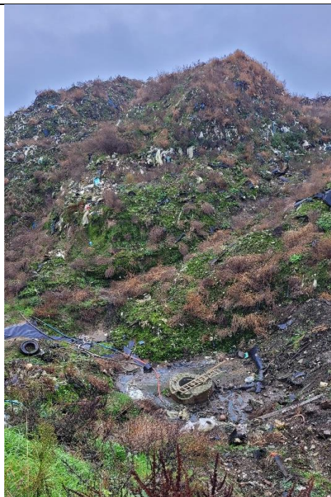
Billede 1 - Udgravning ved opdelingen imellem enhed 2 og 3. Perkolat pumpes til renseanlæg fra brønden.
