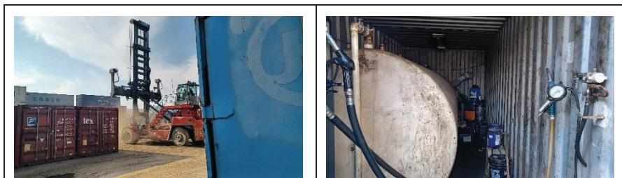
Trucks påfyldes fra egen dieseltank.
