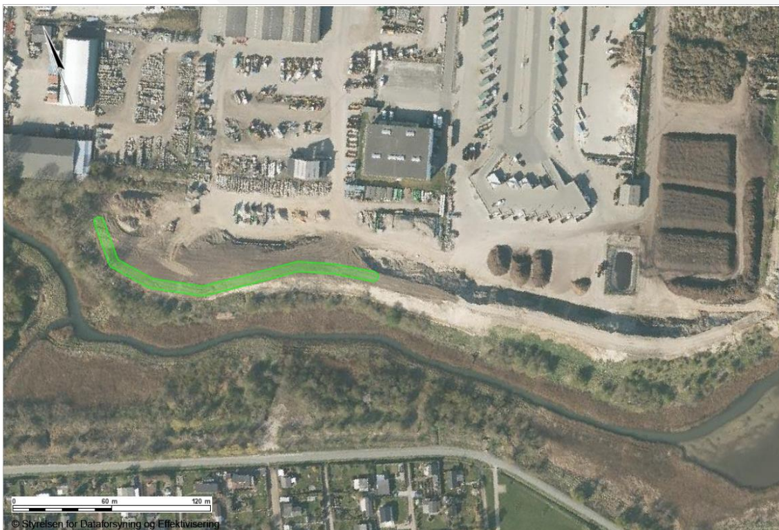
Oversigtsbillede af støjvolden ved endelavevej mod det rekreative område syd for volden. Det grønne område viser området, hvor volden ønskes forhøjes.
