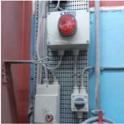
Alarm på filtersystem
