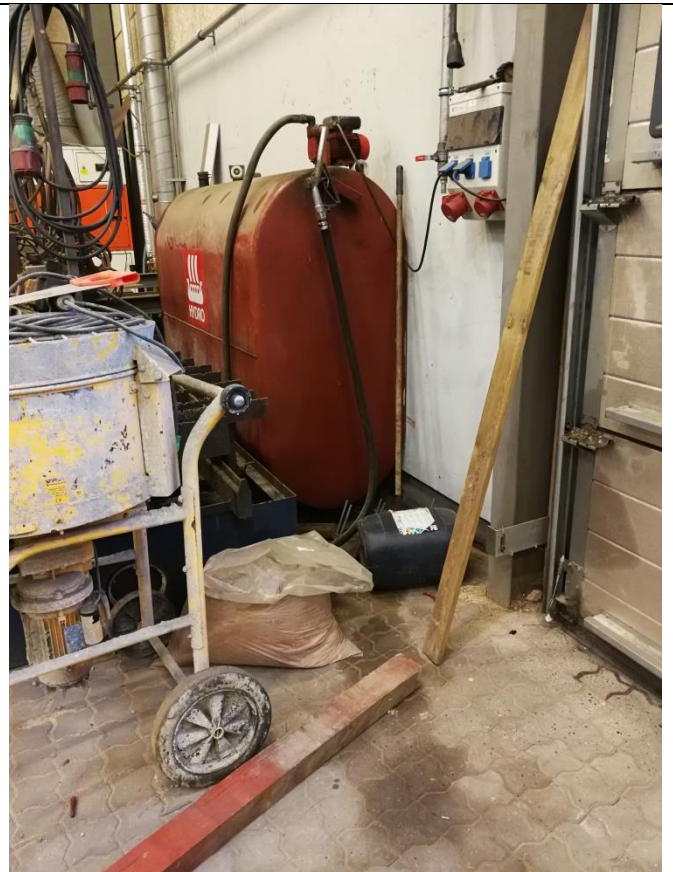
Billede nr. 5: Spild ved dieseltanken – Bygning 2 ved porten mod nord.
