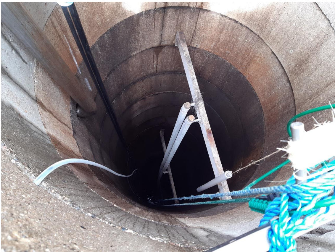
Figur 3: PB1 set oppefra uden forskydninger i ringkonstruktionen
