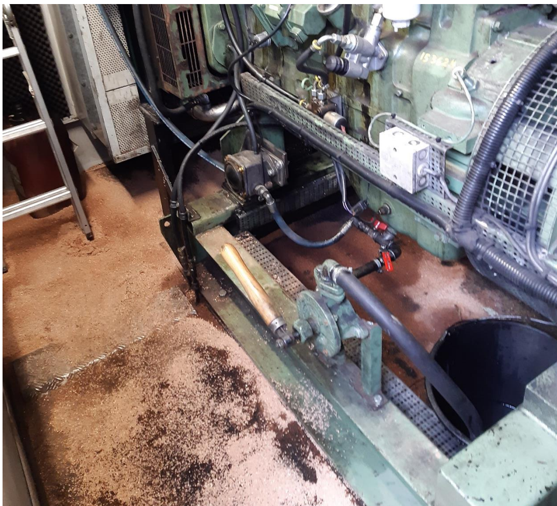
Figur 7: Oliespild omkring gasmotor
