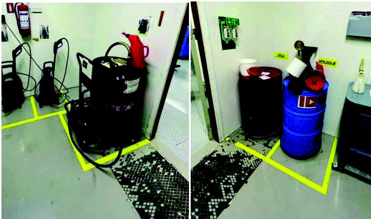
Figur 3.1: Indretning af olierummet med spildbakke i gulvet.
