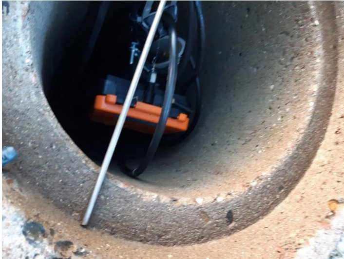
Foto 9: Det indre af grundvandsboring P4. Som det fremgår af billedet er der sat en niveaumåler i denne boring, med det formål at pejle grundvandsstanden under/ved deponiet.
