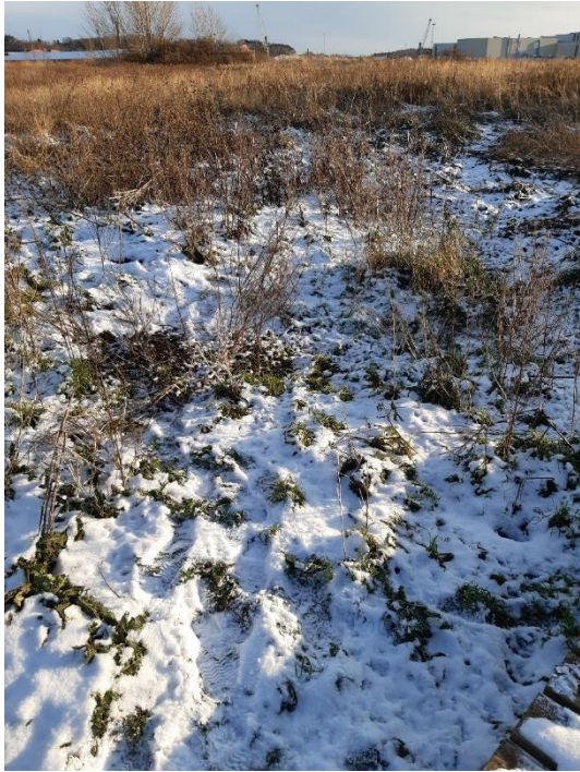
Foto 1: Biocover B2 i deponiets sydlige del. Af billedet fremgår, at komposten er sunket en del i dette biocover i forhold til gangbroen, da gangbroen tidligere var i højde med top af komposten.
