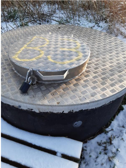
Foto 3: Låg på gasbrønd ved biocover B3. Ved tilsynet fremstod deponiets biocovere inkl. broer og brønde i fin stand.
