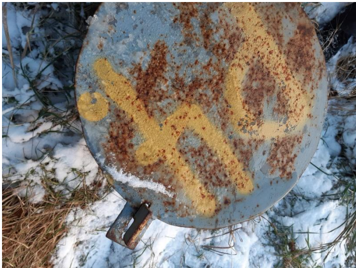
Foto 8: Der var låg og lås på grundvandsboring P4.
