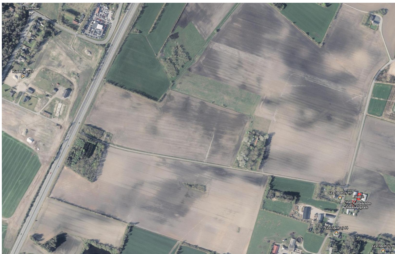
Husdyrbrugets placering i fht. enkelt bolig, samlet bebyggelse og byzone (kort fra Husdyrgodkendelse.dk).
