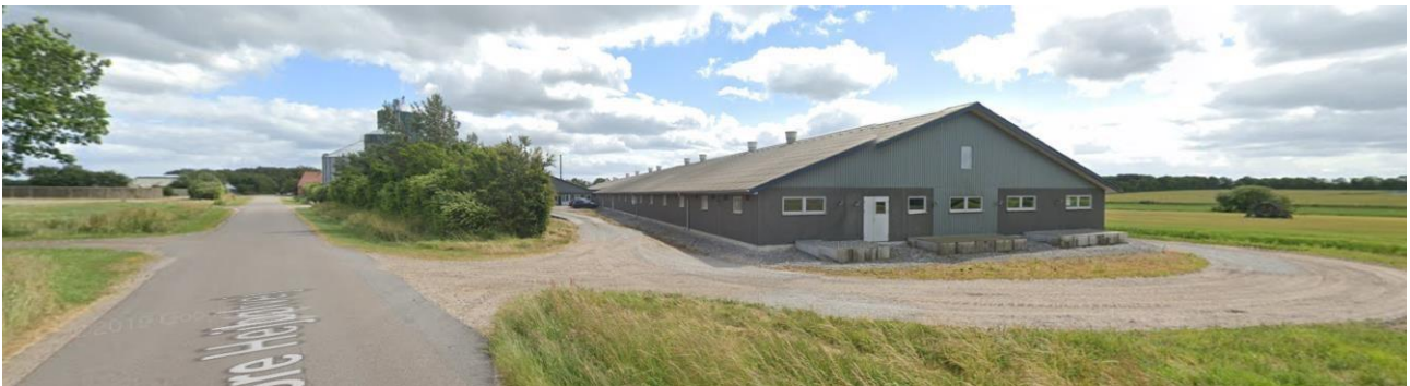
Figur 8 Anlægget fra første indkørsel på Store Hejbølvej.
