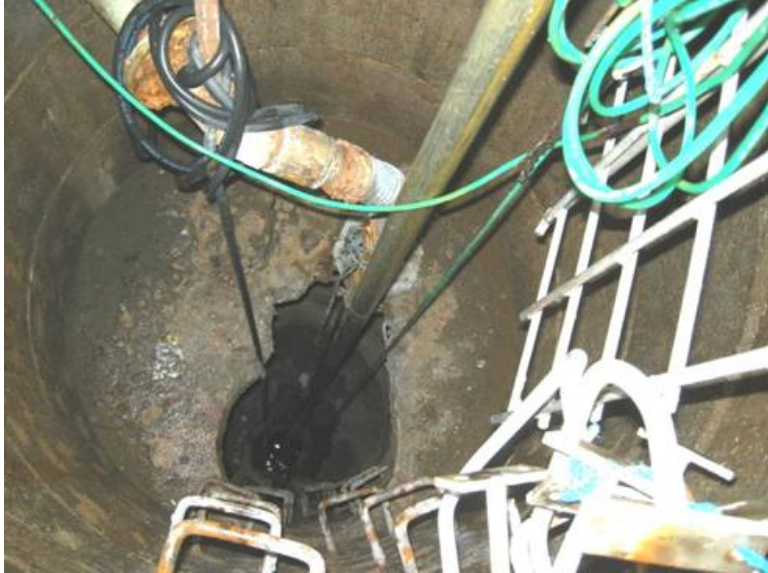
Figur 3.14 Guiderør og trykrør i toppen af CP3.
