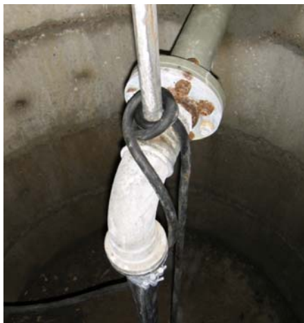
Figur 4.10 Trykledning med hævertbryder i centerpumpebrønd CP2
