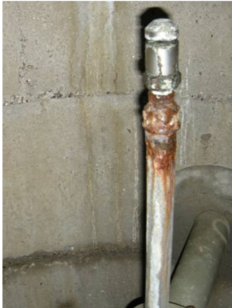
Figur 3.10 Vakuumbryder på CP2's trykledning
