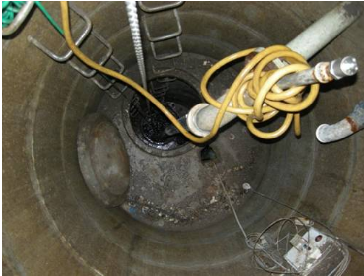
Figur 3.6 Ubenyttet elinstallation i CP1
