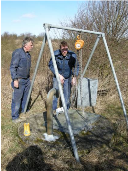
Figur 3.2 Dæksel og talje på toppen af Centerbrønd CP1.
