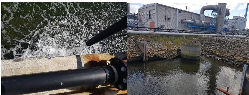
Til venstre; Kølevand der udledes til kølevandskanalen efter skottet.
