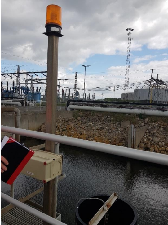
Oliealarmen i kølevandskanalen
