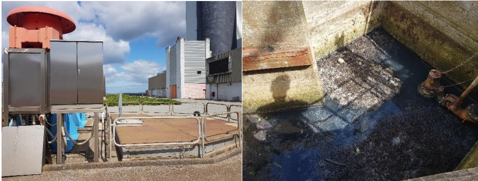
Et af de to kølevandsindtag og et af slambassinerne fra mekanisk rensning af havvandet.
