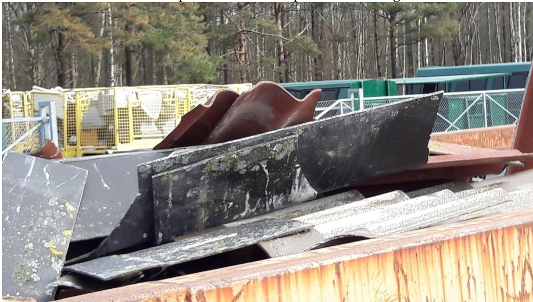
Figur 3: Container til asbest stod uden overdækning under tilsynet.
