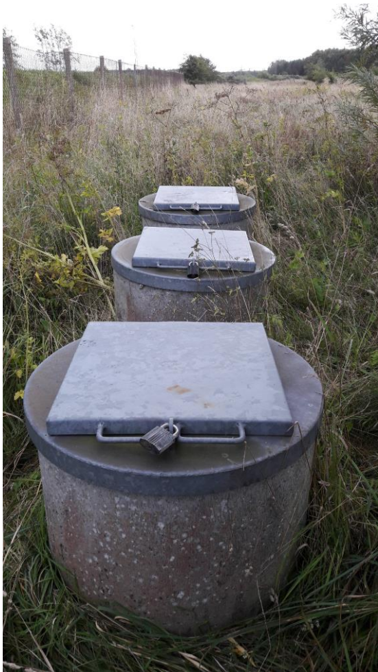
”En nedstrøms boring” men etableret som 3 boreriger ført til 3 forskellige dybder
