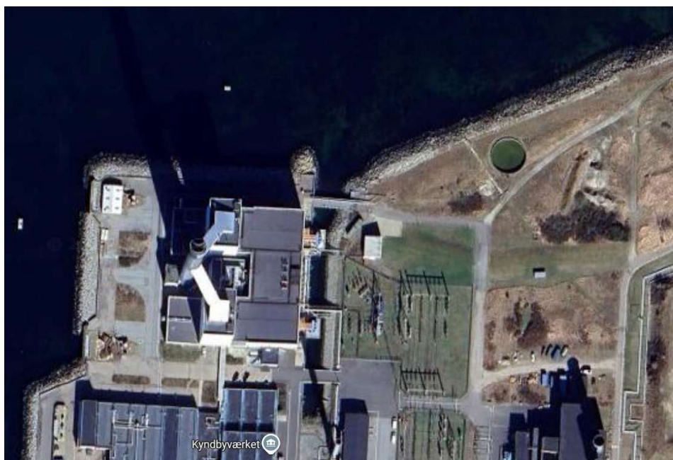
Figur 4 Placering af udløbspunktet i kølevandskanalen ved Kyndbyværket. Kanalen har udløb i Isefjord Ydre. Kilde til figur https://www.google.com/maps/
