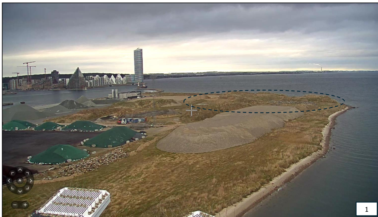
Foto nr. 1 fra oversigtskamera af oliehavnen fra tilsynet 22. november 2024. Det midlertidige jordoplæg ses med omtrentlig stiplede markering. Den forreste jordbunke er sand til forbelastning.
