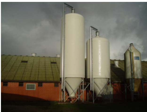
Figur 3-2 Billedet viser tre forskellige udendørs silo, med cyclon for begrænsning af støvgener ved aflæsningen.
