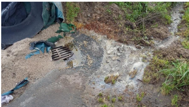
Væske fra ensilageopbevaringsanlæg til løber til ubefæstet ved nordvestligt hjørne af vestligste ensilagesilo. Hvide belægninger
