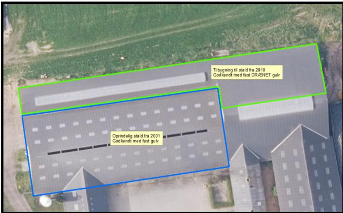
Figur 4 Figur fra tilsynsrapport 2016: Del af stalden der er etableret med fast gulv uden dræn markeret med blå, del af stalden der er etableret med fast drænet gulv markeret med grønt.
