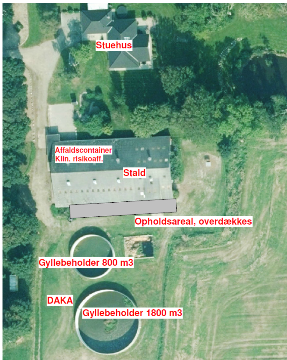
Figur 4: Oversigt over ejendommen
