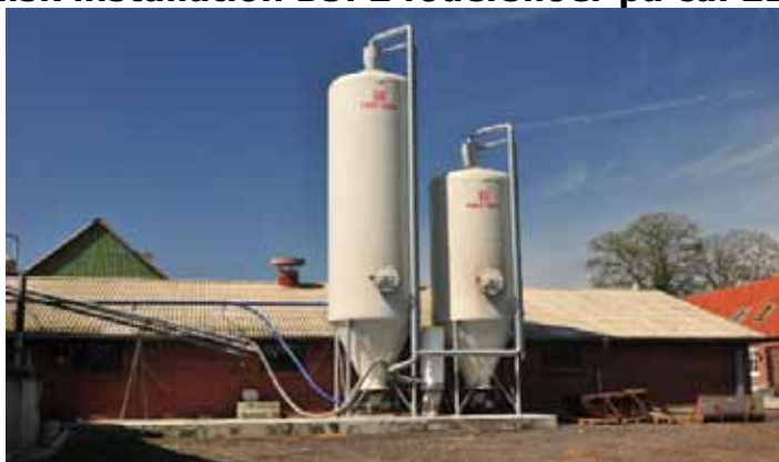
Landbrugsteknisk installation B5. 2 fodersiloer på ca. 22 tons
