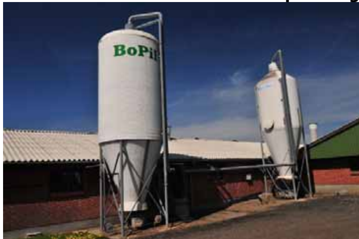
Landbrugsteknisk installation B3. 2 fodersiloer på 20 og 16 tons
