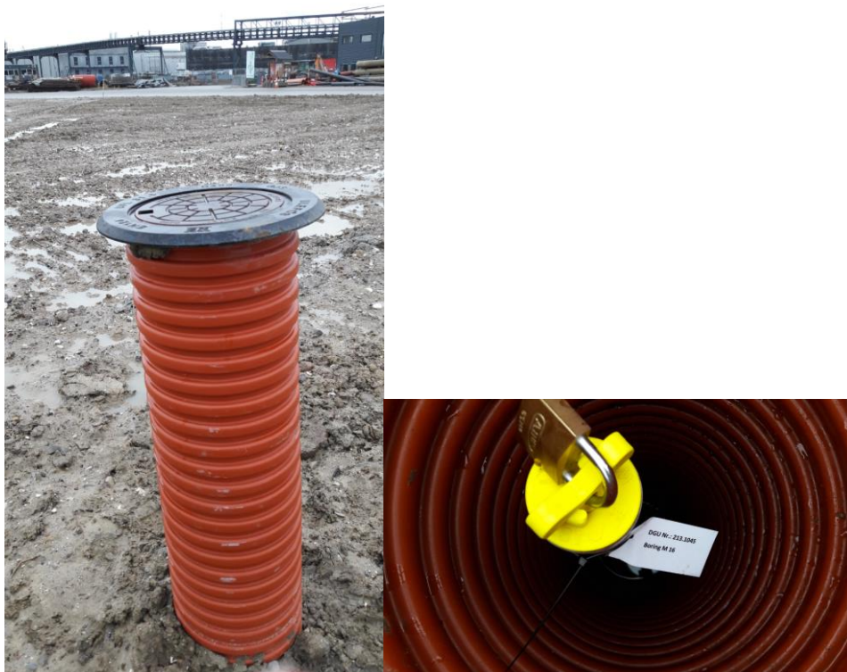
Foto 2: Monitoringsboring M16 med beskyttelsesrør og køredæksel til venstre og med lås og mærkning til højre.
