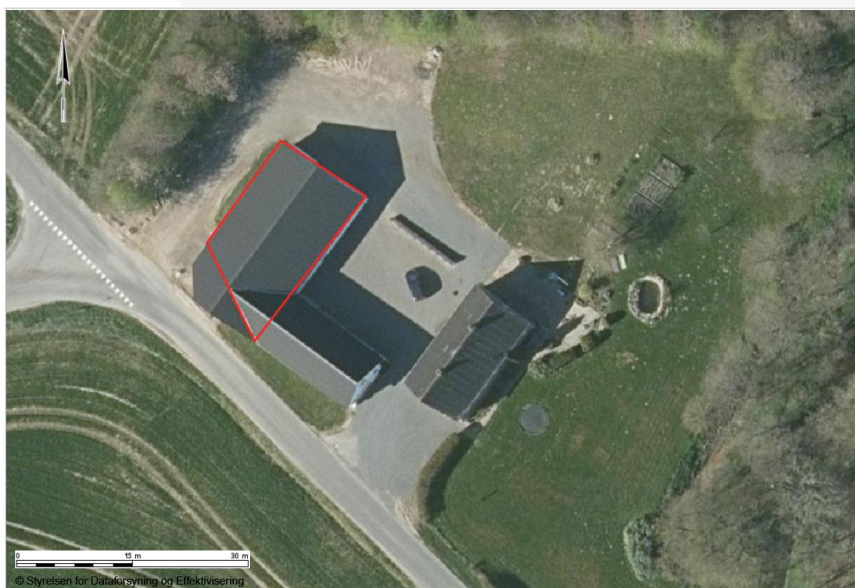
Figur 1: Affaldet oplagres i denne bygning på Kollerupvej 13, 8740 Brædstrup
