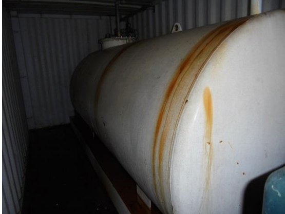
Dieselolietank, spildbakke fyldt med vand.
