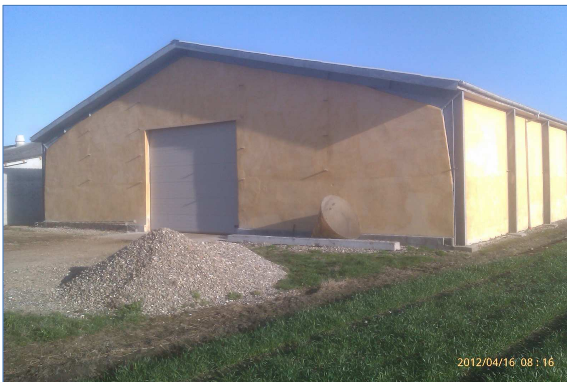
Figur 2: Gødningshuset til opbevaring af fast gødning.
