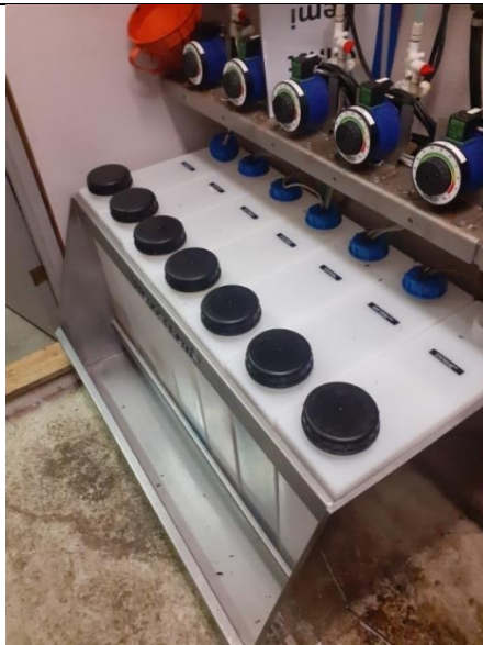
Billede 2. opbevaring af vaskemiddel i spildbakke.
