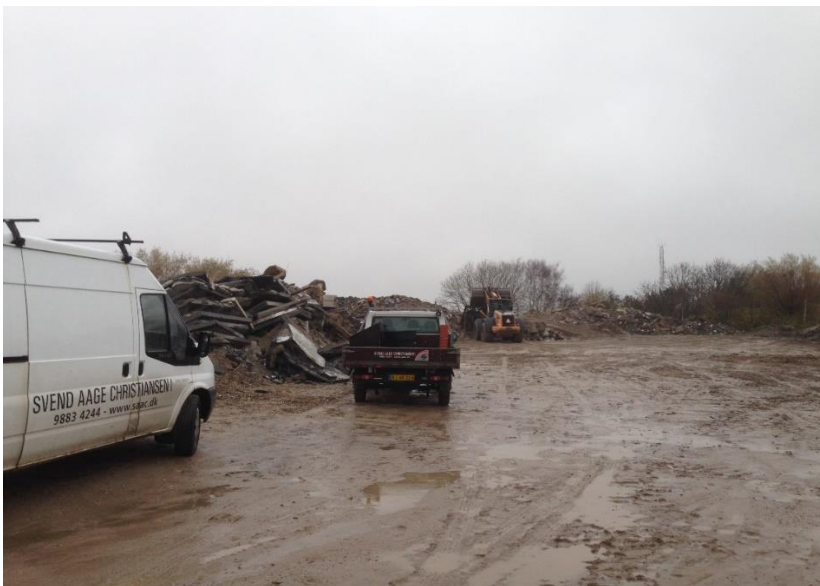
Beton med jord var ved at blive sorteret.
