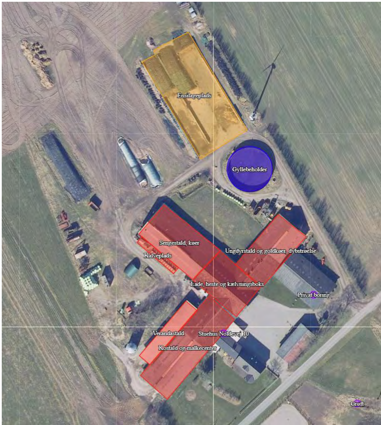
Figur 2: Husdyrbrugets stalde, opbevaringsanlæg mv. på Nøldevej 10. Kilde: husdyrgodkendelse.dk
