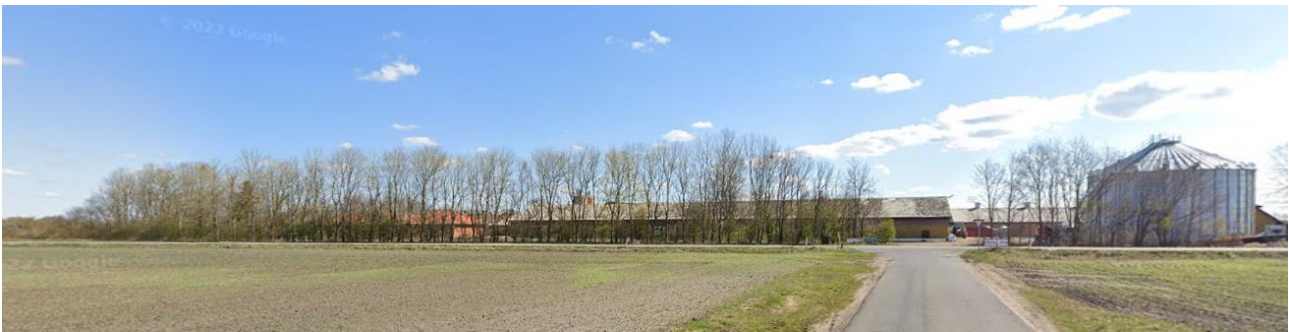
Anlægget set fra vest beliggende langs Ikastvej.
